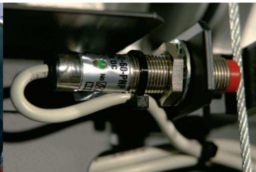
Seilbruch und Schlaffseilerkennung
